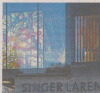
Het werk gezien vanaf buiten.
